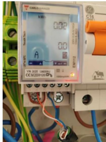
A CAT kábel helyes bekötés a PB eszközben (ellenőrizze az áthidalást)
